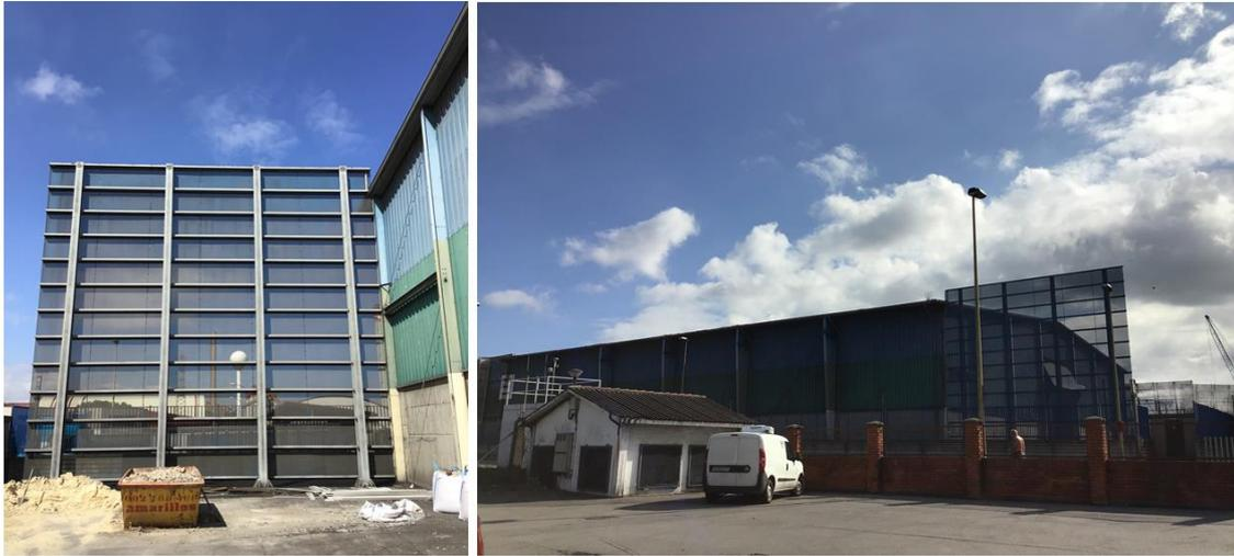
Figura 95. Apantallamientos del Puerto para impedir el paso de las partículas procedentes de los graneles del Puerto
