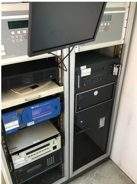
Figura 81. Equipos de medida de la calidad del Aire de la estación Salinas
