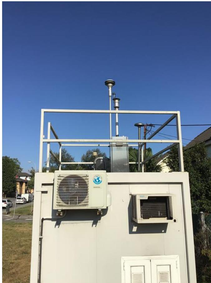
Figura 39. Toma de muestra de gases y partículas y estación meteorológica de la estación Llaranes
