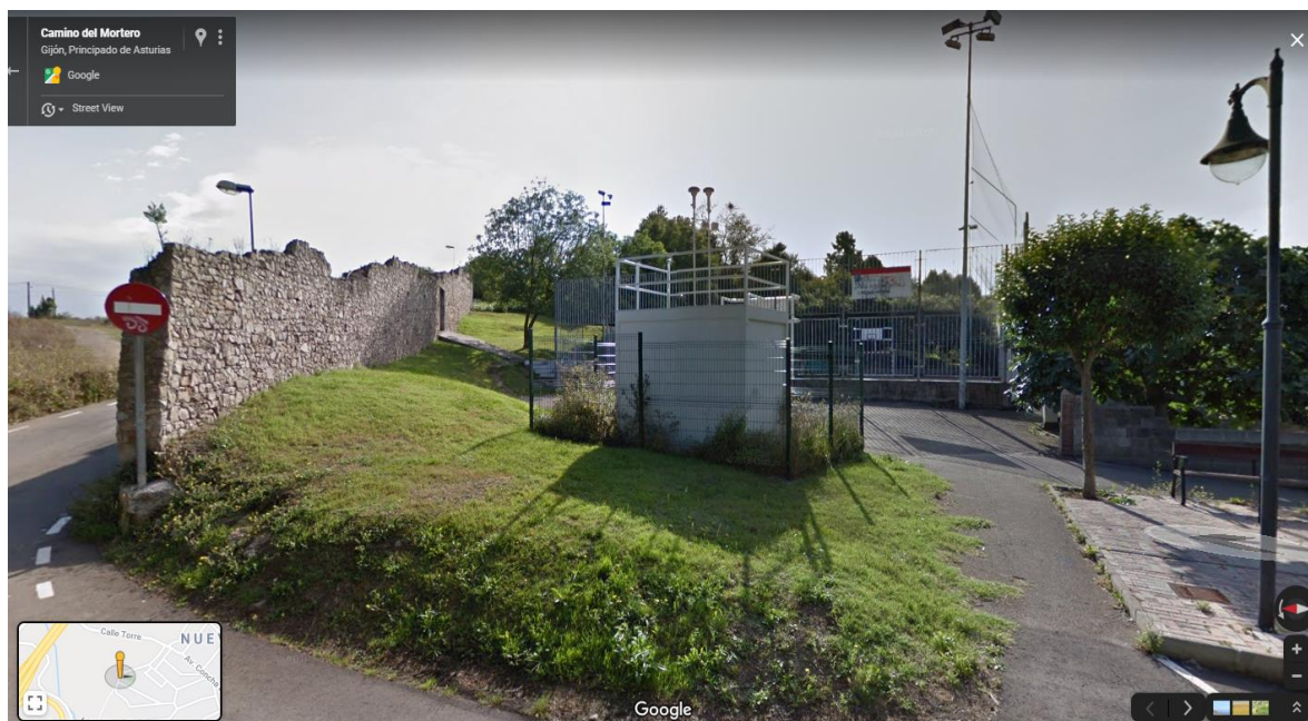
Figura 95. Estación Santa Bárbara (extraído de Street view, Google maps)
