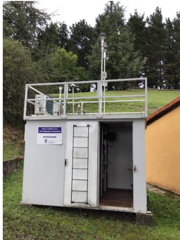
Figura 64. Estación Purificación Tomás
