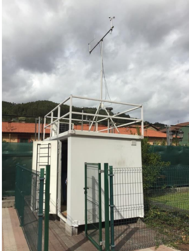
Figura 80. Estación Trubia Piscinas
