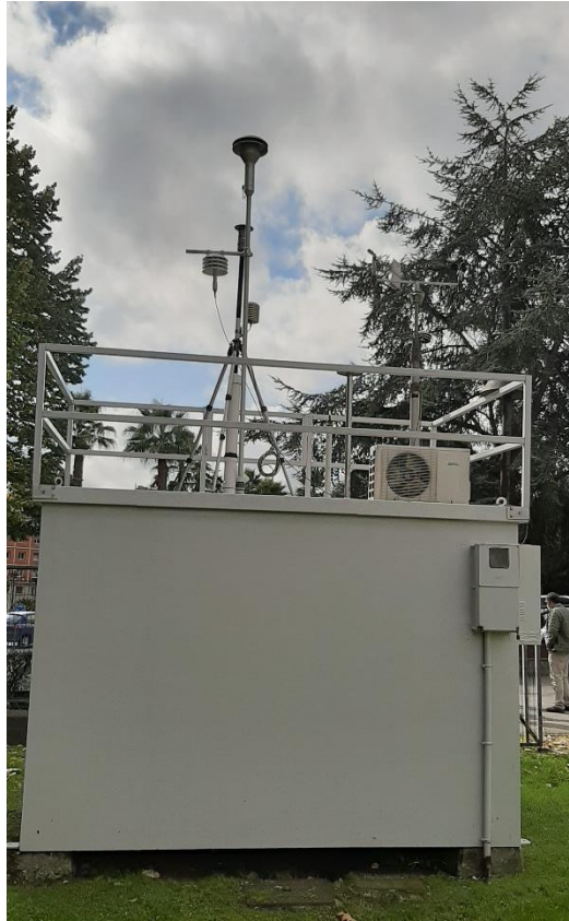
Figura 62. Toma de muestra en la estación Palacio de Deportes
