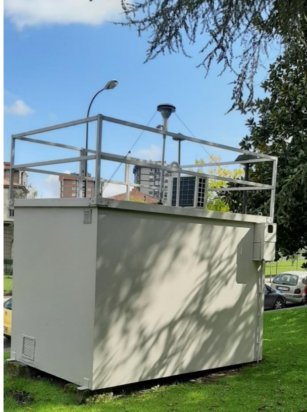
Figura 24. Estación Plaza de Toros
